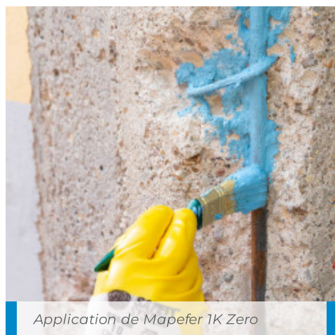
Application de Mapefer 1K Zero sur des armatures d'un viaduc
