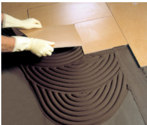
Pose de grès cérame sur une chape imperméabilisée avec Mapelastic
