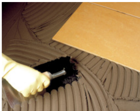
Application de Elastorapid avec une taloche crantée sur une chape de ciment
