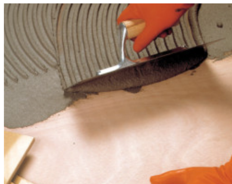
Pose de grès cérame avec Elastorapid sur panneau de bois multicouche marine
