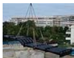
Puits canadiens / ventilations
