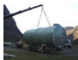
Réservoirs eau potable
