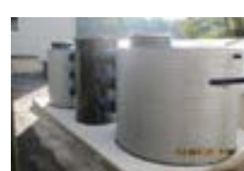
Fosses de pompage
